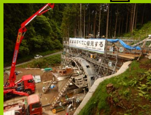
村田側坑口 坑門コンクリート打設状況
