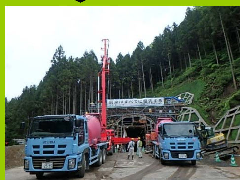
村田側坑口 坑門コンクリート打設状況
