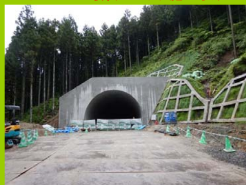
村田側坑口 坑門コンクリート打設状況
