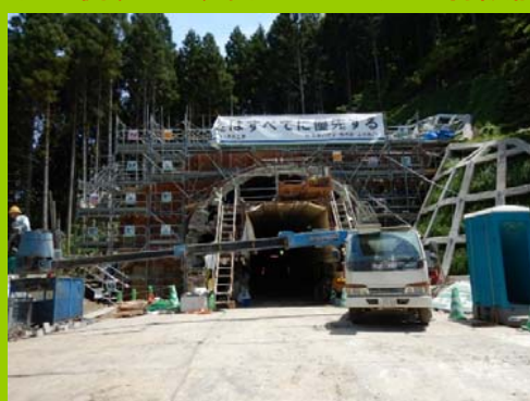
村田側坑口 坑門コンクリート打設状況
