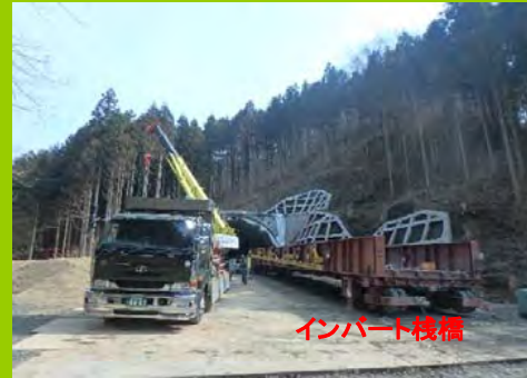
村田側坑口 インバート棧橋解体状況
