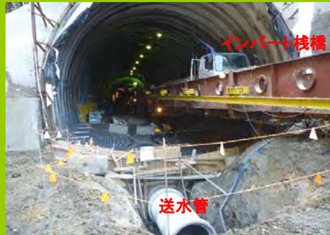
村田側坑口 インバート最終ブロック施工状況
