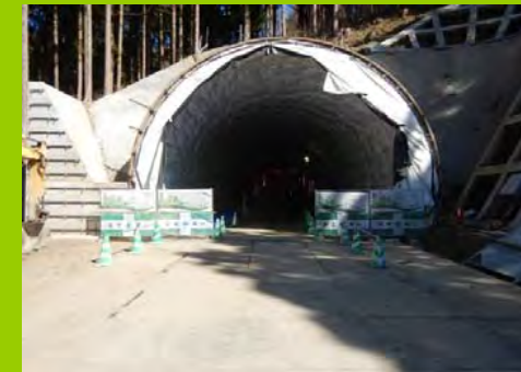
村田側坑口全景
