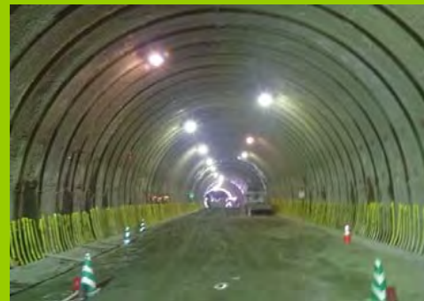
トンネル坑内 終点(村田)側 状況
