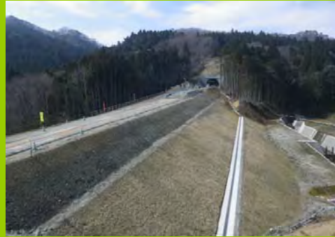
岩沼側坑口全景
