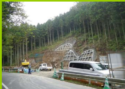
終点坑口(村田町側)
